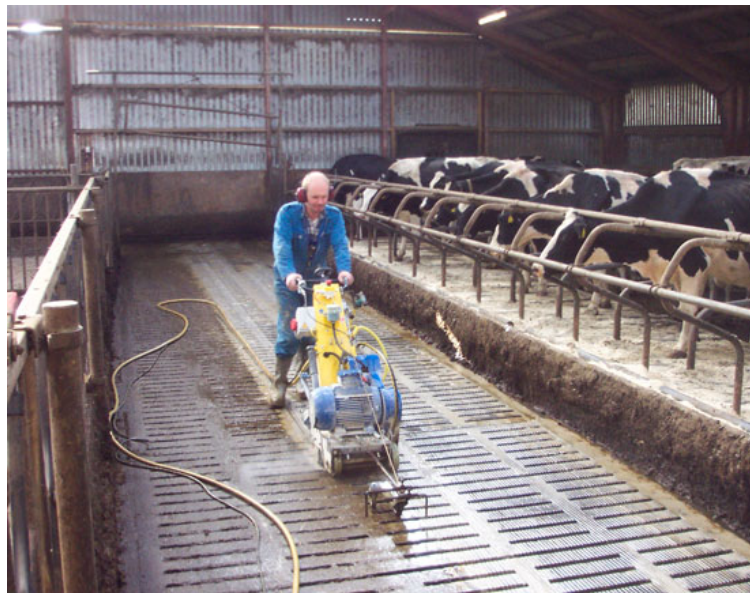
Rilleskæring er en forbedring: Glatte gulve bliver skridsikre. Foto: René Christensen, Ballum og Skærbæk IT
